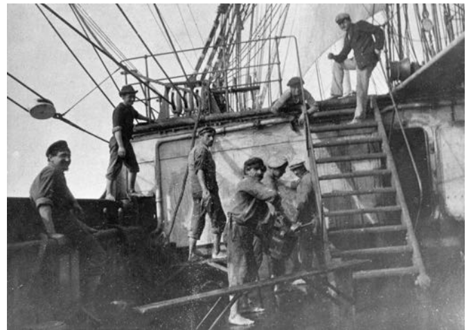
Piquer la rouille et passer du minium, c'est entretenir le navire ; laver les surfaces à la potasse et les peindre lui redonnent sa beauté.
